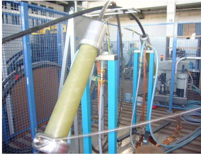
Abbildung 2: 150-kV-Prüfendverschlüsse zur Durchführung des FGH-Stufentestes
